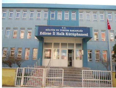
Şekil 2 Edirne Halk Kütüphanesi Binasının Dıştan Görünümü
