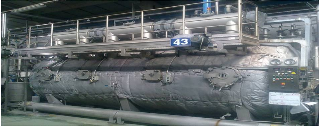
Şekil 2.18 : Boyama makinelerine izolasyon uygulaması.
