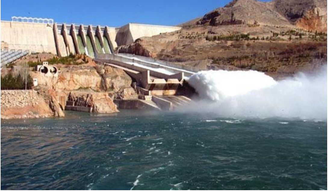
Şekil 2.10: Keban Barajı ve hidroelektrik santrali (HES).
