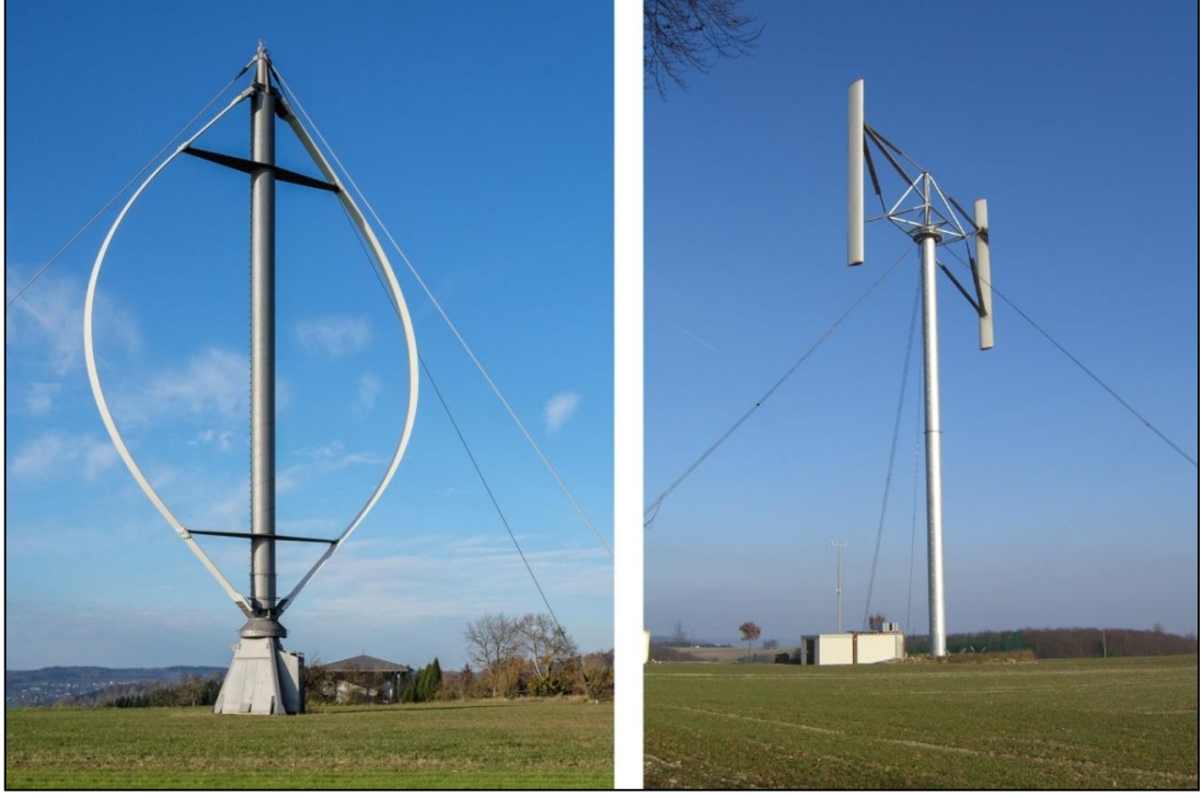
Şekil 3.13: a) Darrieus b) H-Darrieus Rüzgar Türbin Tipleri.
