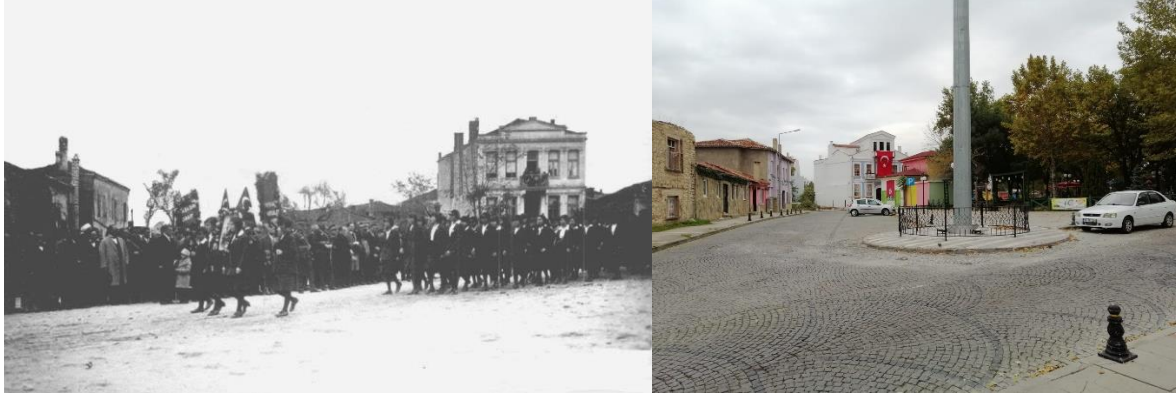
Şekil 14. Yayla Mahallesi meydanı eski durumu (solda) [20] ve mevcut durumu (sağda)
