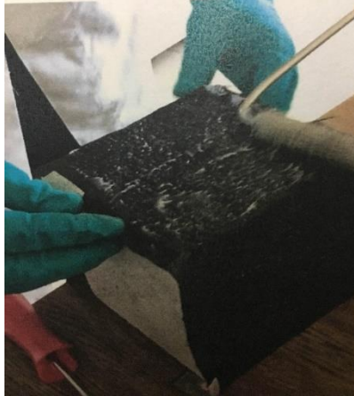
Şekil 1: Karbon kumaşın beton üzerine uygulanması
