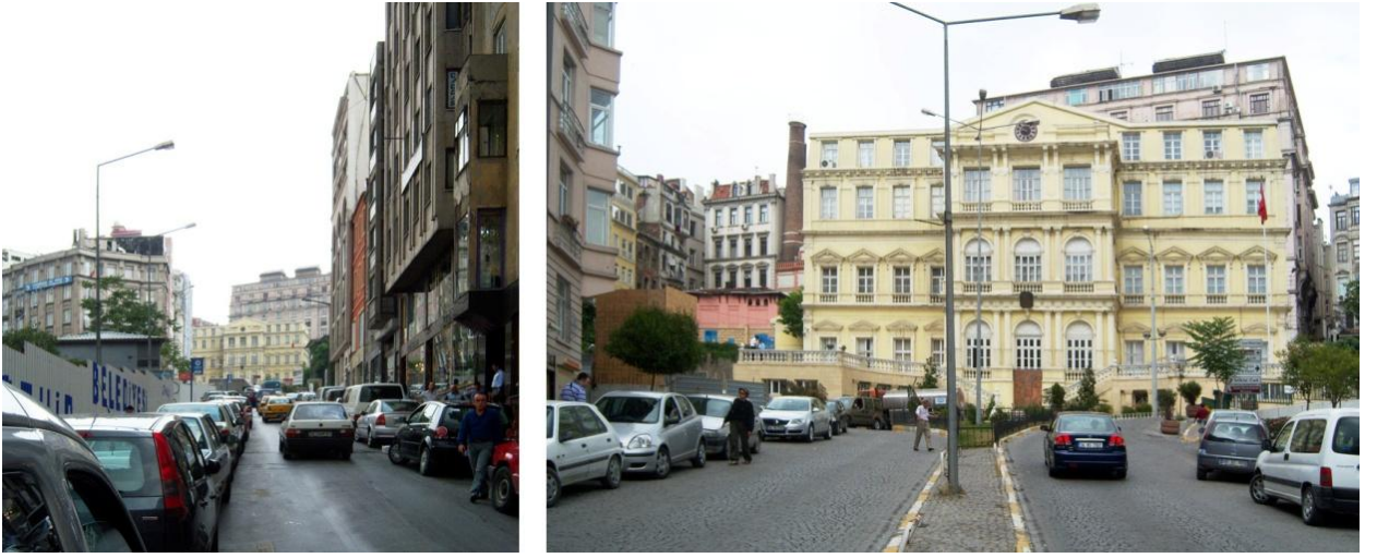
Şekil 14- Beyoğlu Belediye Binası. Eski Altıncı Daire. (Birik M. 2011).
