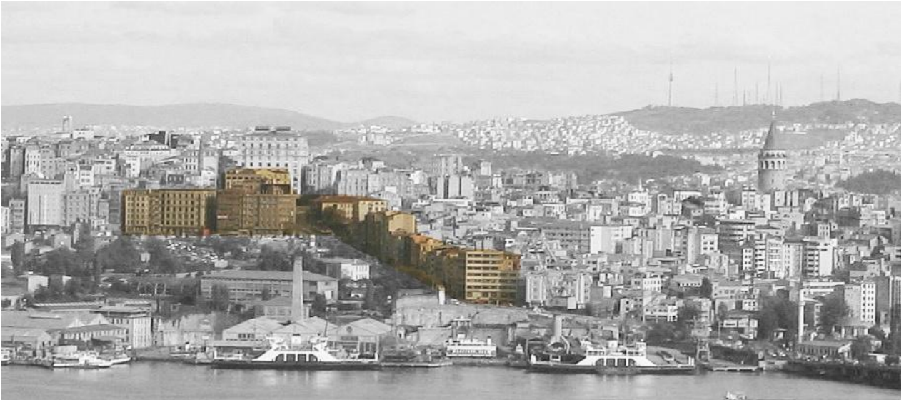
Şekil 18 Kentsel arayüz olarak Şişhane Meydanı'nı çevreleyen yapı cepheleri. Tarihi Yarımada'dan bakış.
