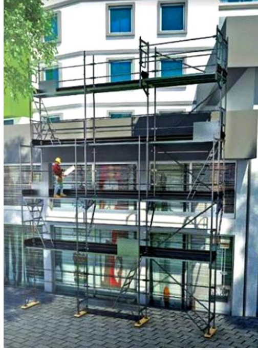
Şekil 3.5. H tipi iskele örneği
