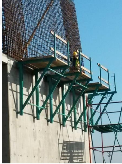
Şekil 3.4. Çıkma konsol ve çelik çıkma iskele örneği
