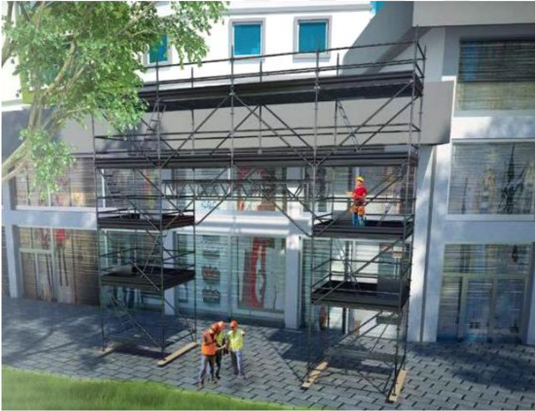
Şekil 3.8. Flanşlı iskele örneği
