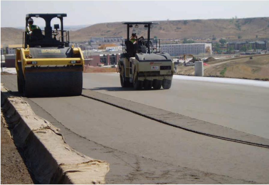
Şekil 4.3: SSB silindirle sıkıştırılması (Andriolo R.F, 1998).
