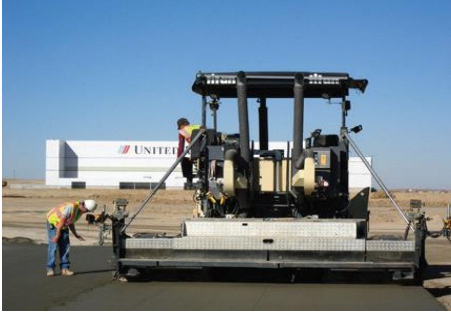
Şekil 4.2: SSB yol serim uygulaması(Andriolo R.F, 1998).
