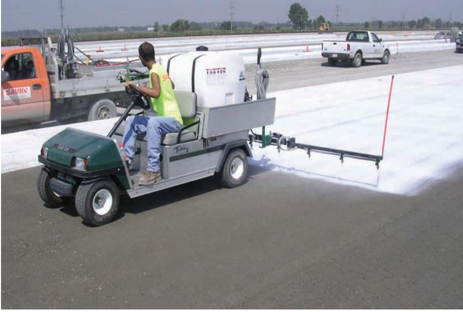
Şekil 4.4: Kür malzemesinin uygulanması(TÇMB, 2017).
