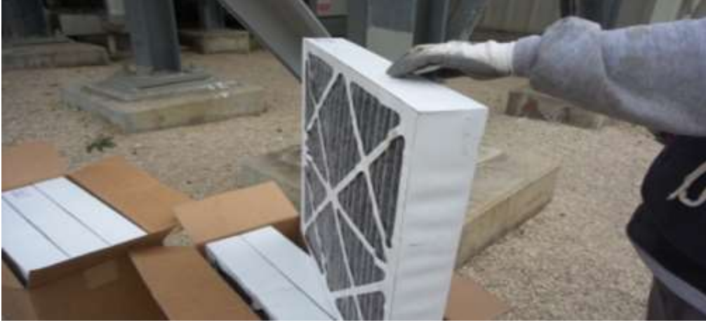
Şekil 3.5 (2019) : Filtrenin uygunsuz temizliği.
